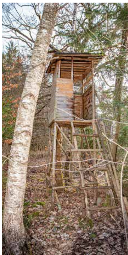
Auch Zugänge müssen sicher sein
