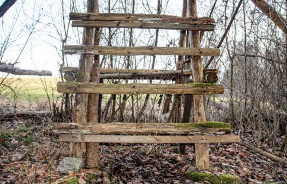
Bei so einer Leiter erübrigt sich die Reparatur
